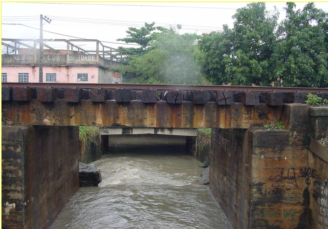
**Figura 1: Estreitamento do leito do rio Botas para a passagem do transporte ferroviário. Fonte: PROURB (julho/2006).**
