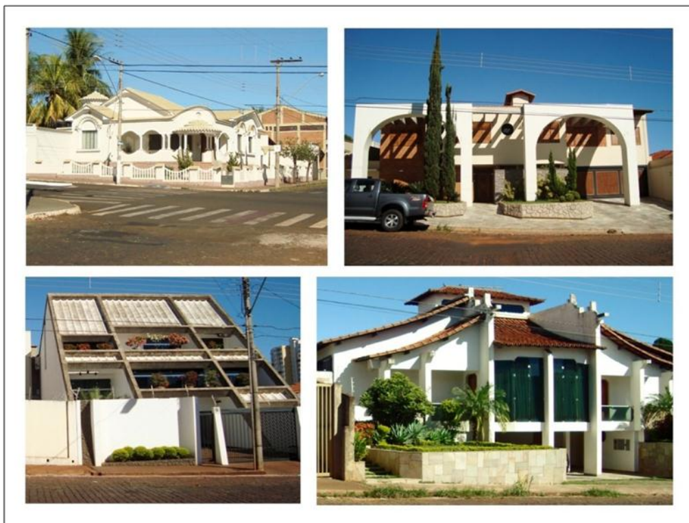
Figura 05: Visualização parcial das casas de alto padrão construídas próximas ao complexo de galpões antigos de uma família tradicional.
