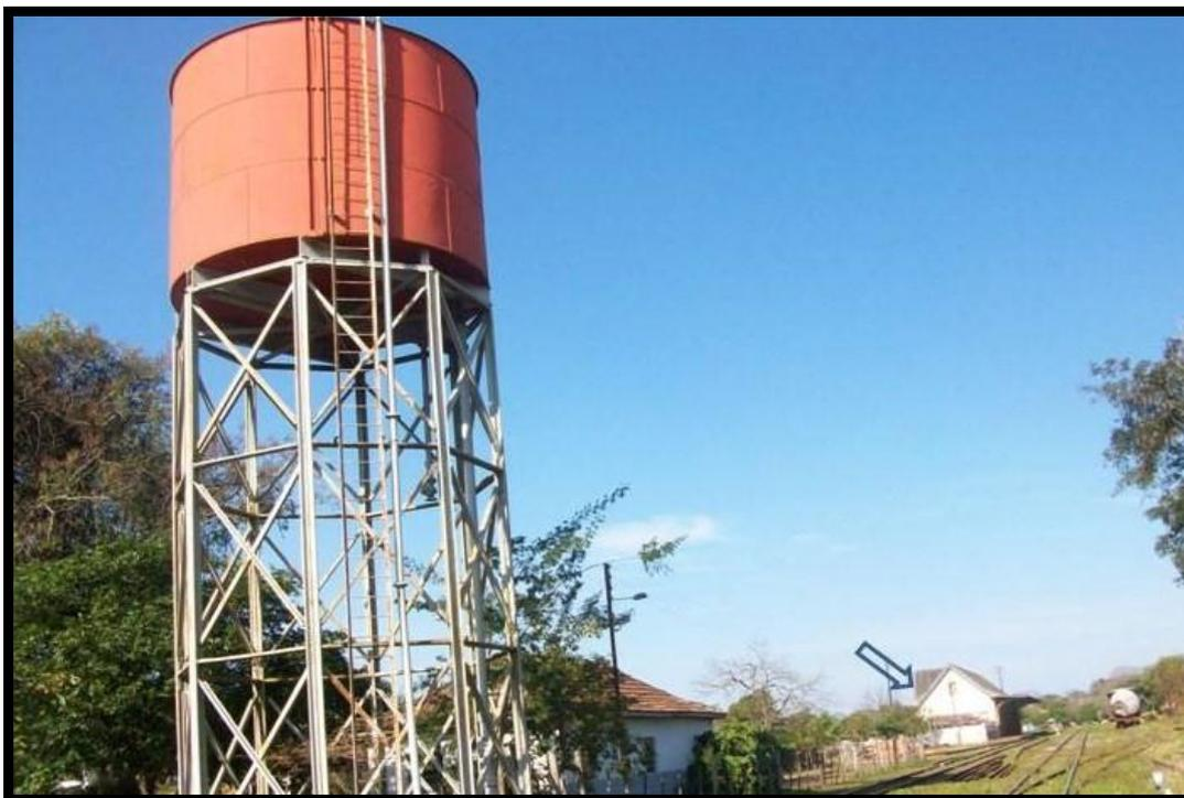
Figura 4: Fotografia da Caixa d' Água, construída no ano de 1885, antes da Estação Restinga Sêca (indicação azul), abastecia as locomotivas. É o único patrimônio ferroviário do município que passou por um processo de recuperação entre 2003 e 2004.
